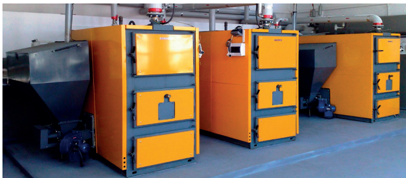
Realizacja kotłowni kaskadowej 3 x kotły BIOPLEX HL (1221 kW) – Koncern Energetyczny Tauron Opole
